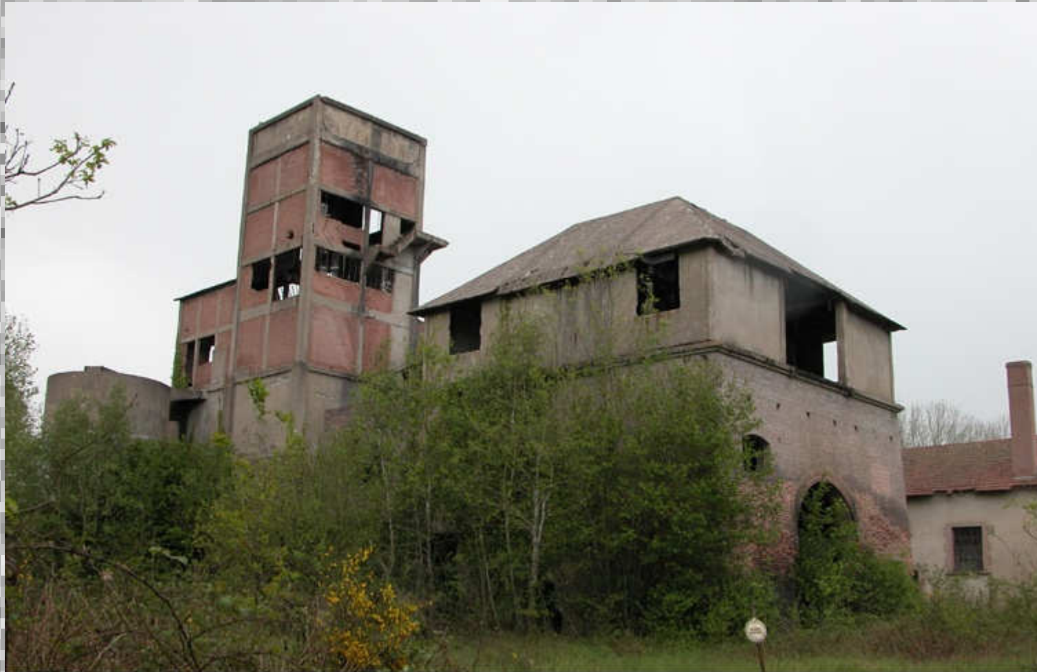
Le carreau du puits Quatre des Houillères d'Ahun, à Lavaveix-les-Mines (Creuse) : le puits et le lavoir à charbon. Lazaj, Jehanne © Inventaire général, ADAGP, 2006.
