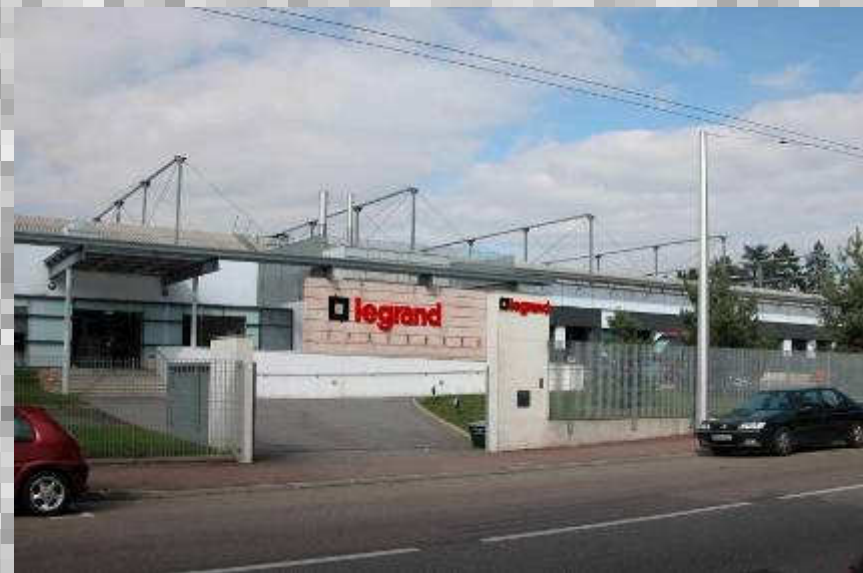
Usine de construction électrique Legrand - / Limoges (Limousin) Pillet, Frédéric - © Inventaire général, ADAGP, 2003
